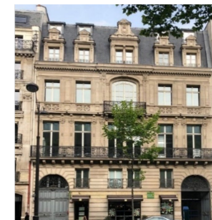
EDIFICIO AVENUE KLEBER 8 PARIS
