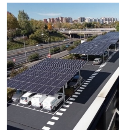
EDIFICIO IRIS MADRID
